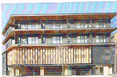
京都木材会館（平成28年3月竣工）
